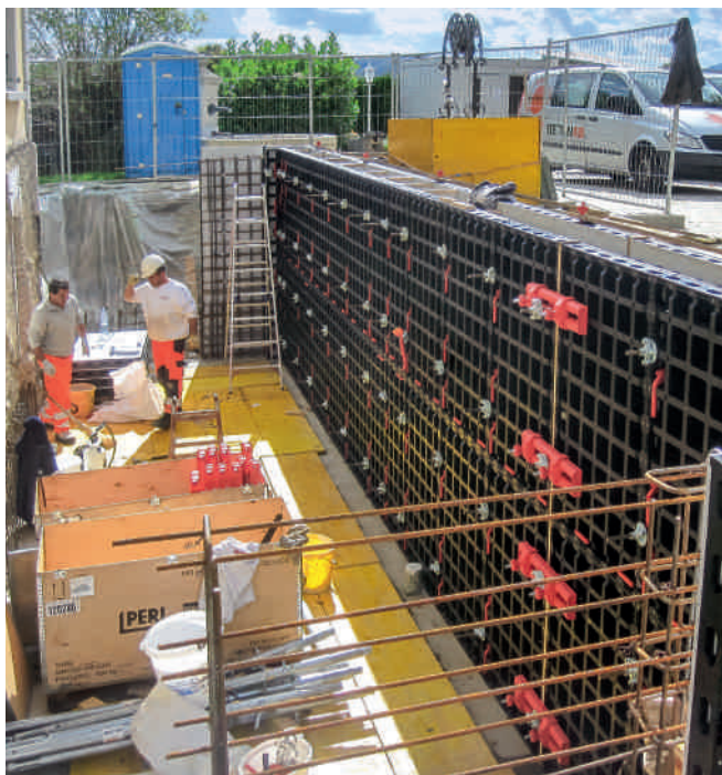
Přestavba a nástavba bez nasazení jeřábu – skvěle vyřešeno se systémem DUO
