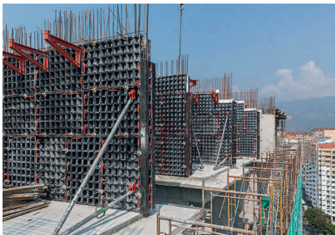
Úspěšné první nasazení lehkého systémového bednění pro zhotovení stěn
