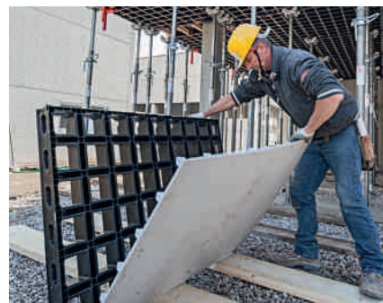
2. Odstranění poškozené desky
