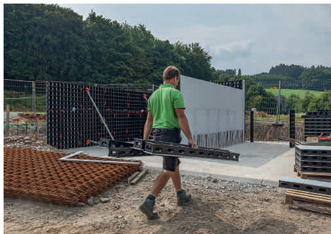
„Začátečníci v bednění“ ze zahradnického a krajinářského provozu využili DUO při bednění boxů pro sypké hmoty
