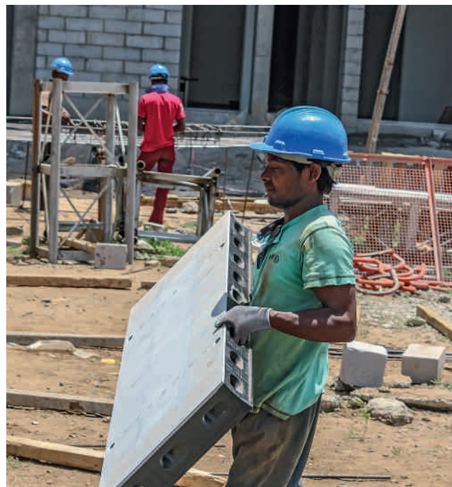
Rychlé bednění a odbednění v Indii
